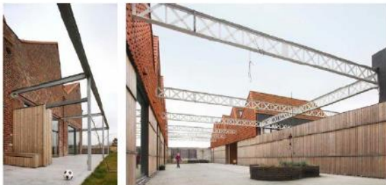
Voortbouw van een textielabriek tot een project voor 6 woontoren, 1 atelier en 2 kamoruimtes in Roesse, Volk architecten
